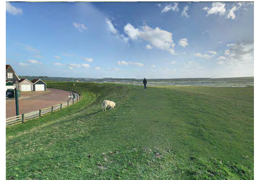
Figuur 14: De dijk herkenbaar en open zicht naar de uiterwaarden
