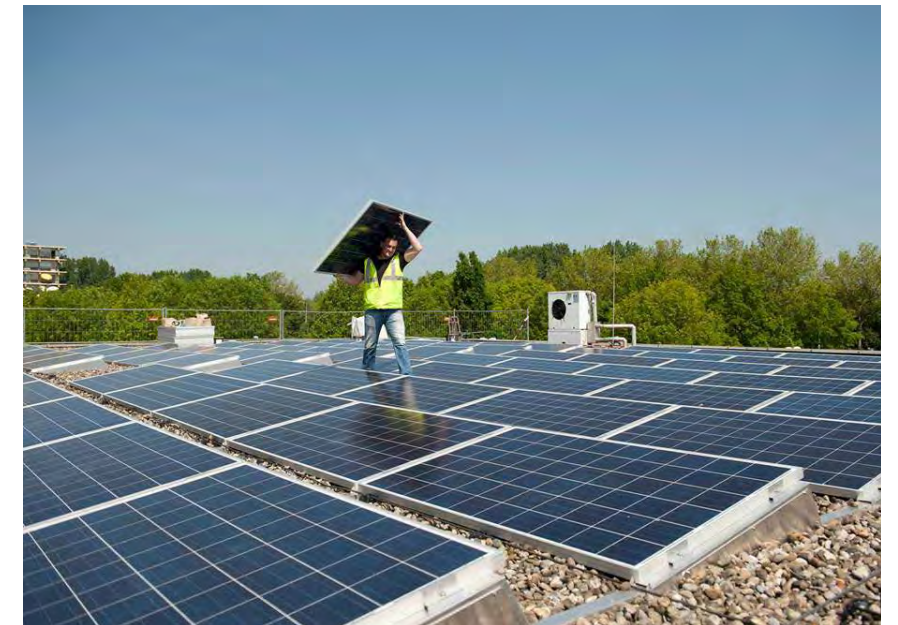
Figuur 54: Bedrijfsdaken met zonnepanelen
