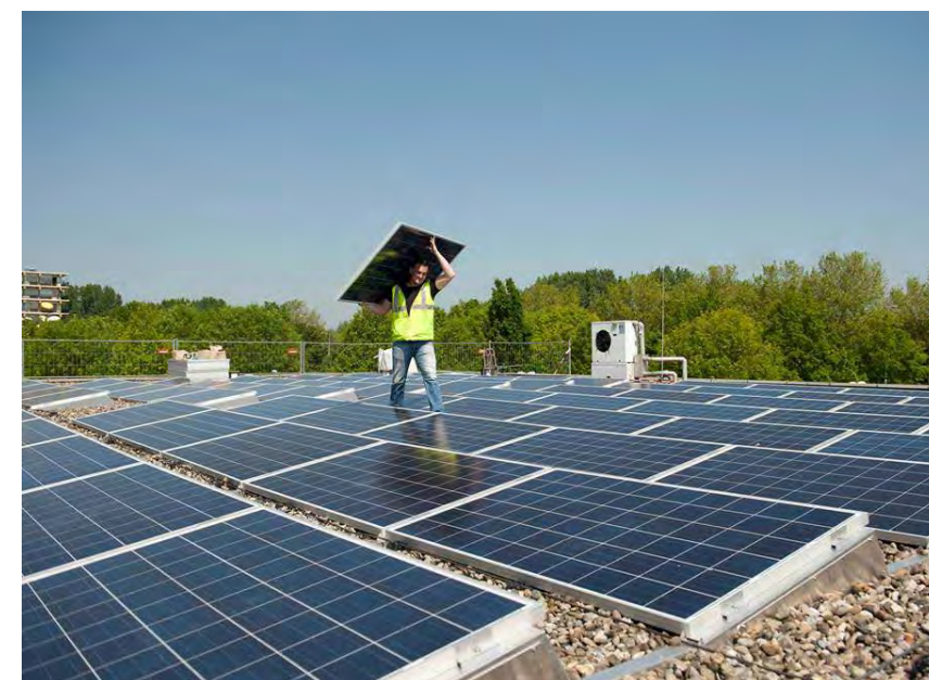
Figuur 52: Bedrijfsdaken met zonnepanelen
